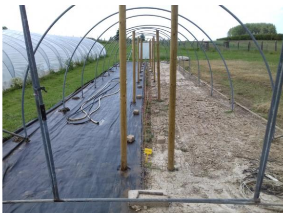
Figure 6 : Nettoyage en cours de la toile au sol du tunnel au 15 juin 2021
